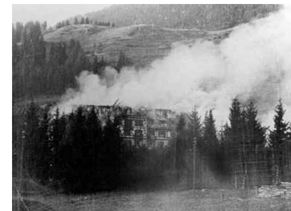
Beim in der Küche ausgebrochenen Brand wurde die Kurhaus-Kuppel zerstört – historische Fotografie vom 9. August 1949
