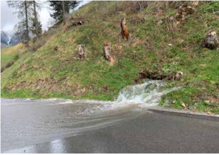
Die gleiche Stelle vor der Schaffung der auf Seite 10 sichtbaren notdürftigen Untertunnelung
