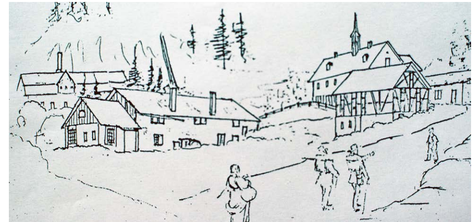
Bellaluna im Juli 1859. Gebäude im Vordergrund, vor dem Direktionsgebäude: Dort und in möglicherweise bereits zurückgebauten Gebäuden waren vermutlich die Anlagen für die Blei- und Zinkverhüttung installiert. Im Hintergrund das grosse Gebäude mit den Anlagen für die Eisen- und Stahlproduktion auf der rechten Talseite. Aus dem Dach herausragend: Kamin für die Hochofenabluft.
