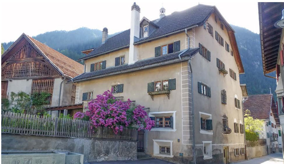
Haus Lorenz an der Hauptstrasse in Filisur
