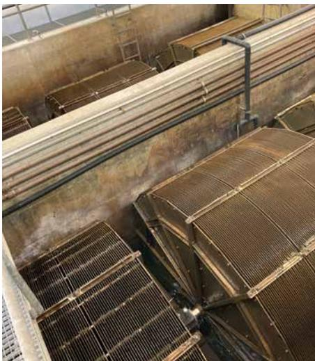
Blick auf die Tauchtropfkörper (TTK) – rotierende Rollen mit bakterienbewachsenen Lamellen
