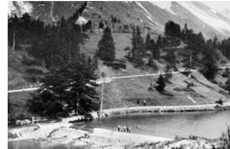
Wasserfassung am Palpuognasee Bauzustand 1916
