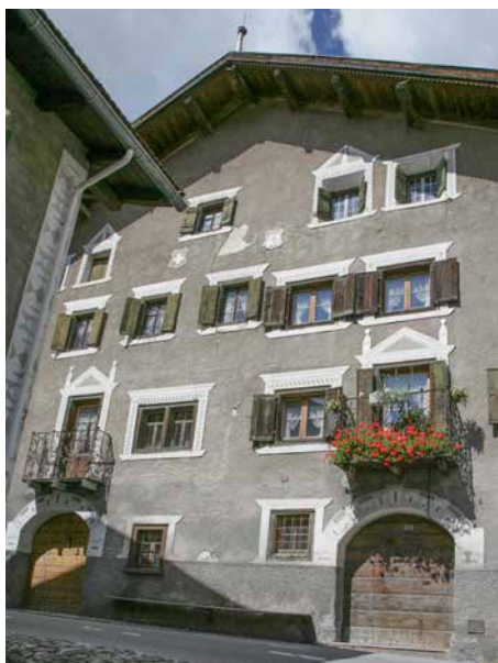
Haus Cos vor der Renovation © Ricabeth Steiger
