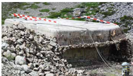
Bunker an der Albula-Passstrasse
