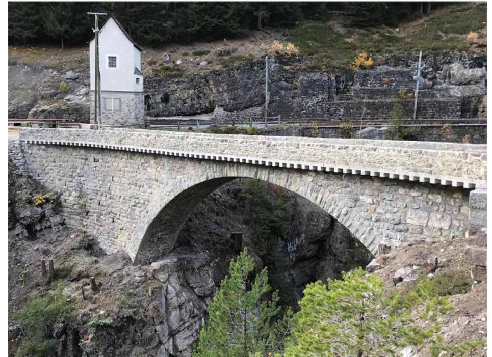
Ansicht der zur Strassenverbreiterung mit einem Konsolgesims neugestalteten Brückenseite
