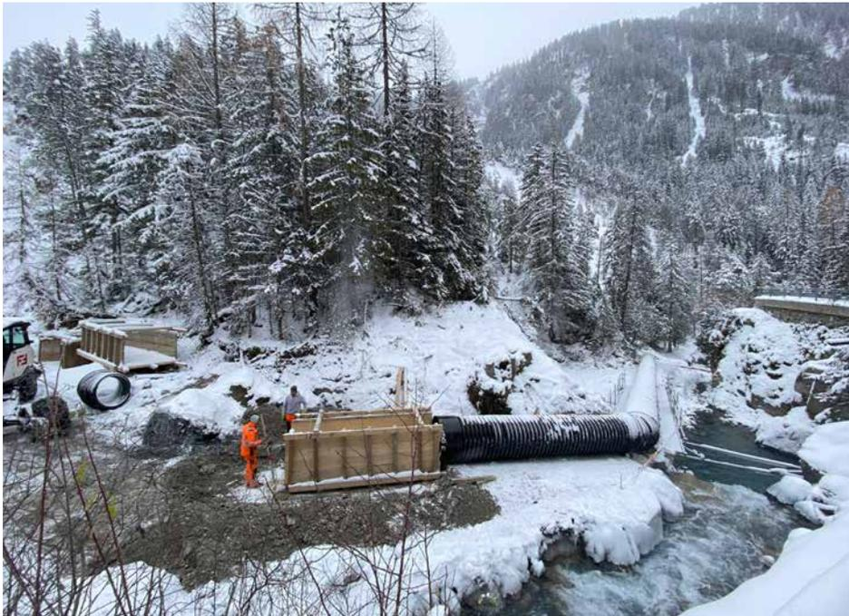
Mit gross dimensionierten Röhren wurde die Überbrückung der Versickerungstelle vorbereitet
