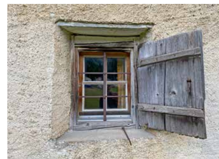
Originaler Fensterrahmen und Balken
