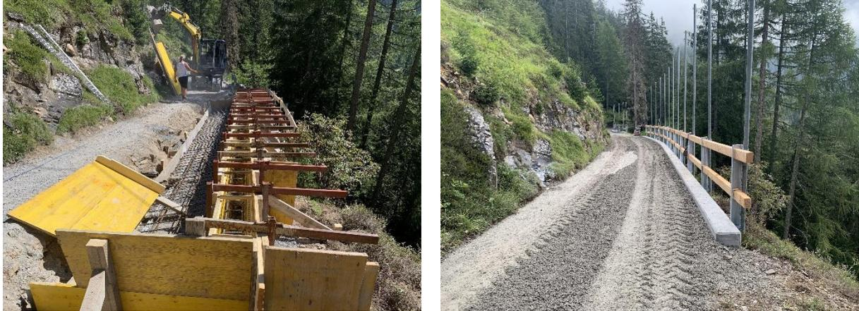
Bild li während den Bauarbeiten re nach Abschluss der Instandstellung (Fotos U. Fliri)
