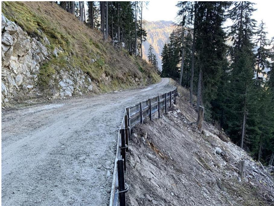
Gesicherter Wegabschnitt durch verankerte Pfahlwand; zusätzlich zu den geplanten Massnahmen im Rahmen des Projekts erstellt und finanziert 09.11.2020 (Foto: U. Fliri)
